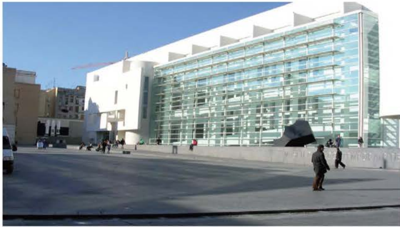
IMATGE E. Façana del MACBA. Barcelona, 1995.
